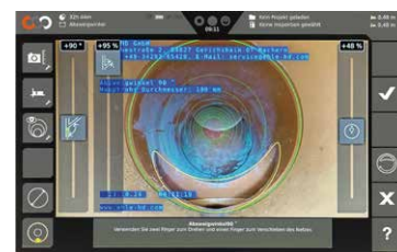
VERMESSUNGEN IM ROHR
