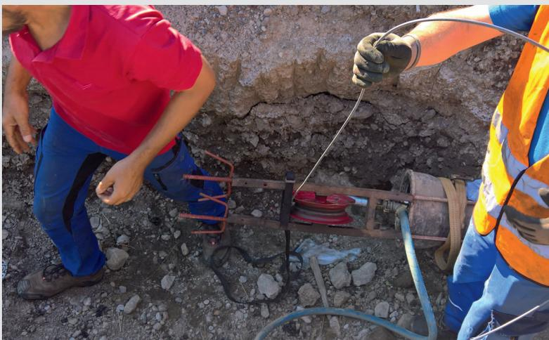
**Bild 7:** Absperrblase eingebaut mit Druckluftanschluss und Umlenkrolle für das Lichtwellenleiter-Kabel
