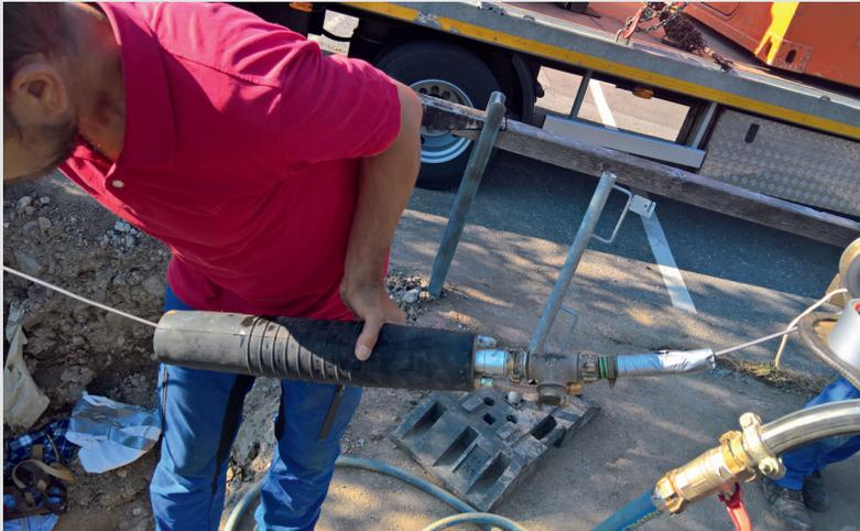
**Bild 6:** Absperrblase mit Durchführung, T-Stück mit Kompressoranschluss und druckdichte Kabeldurchführung
