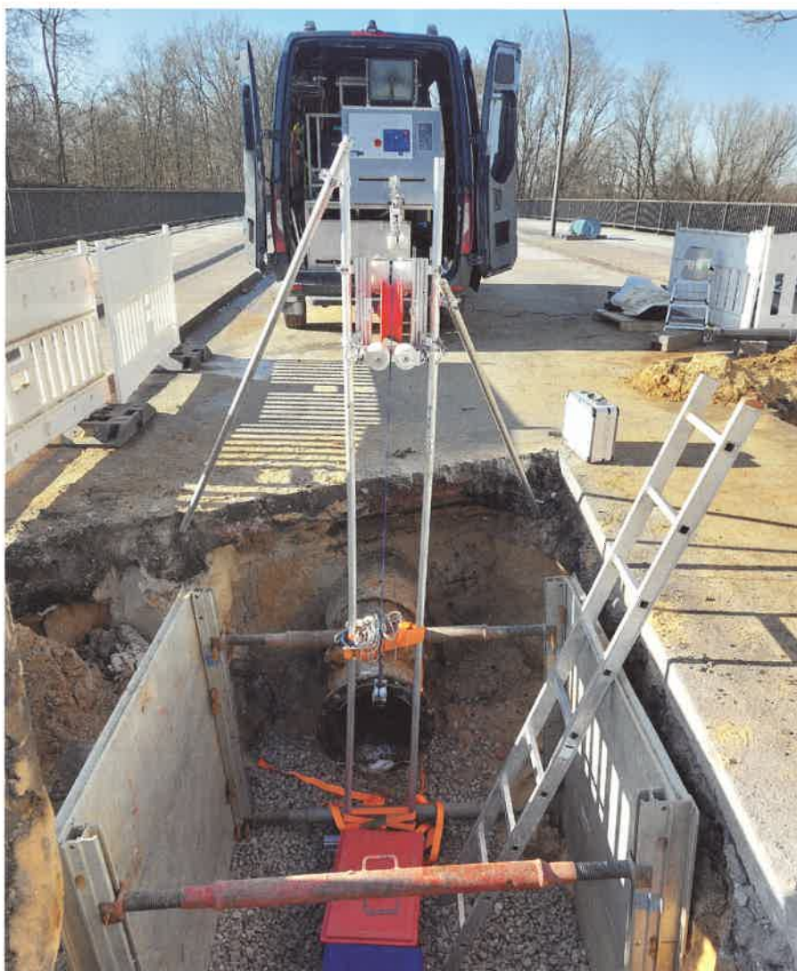
Bild 1: Durchführung einer Kamerauspektion mit dem Gullyver II Systems
