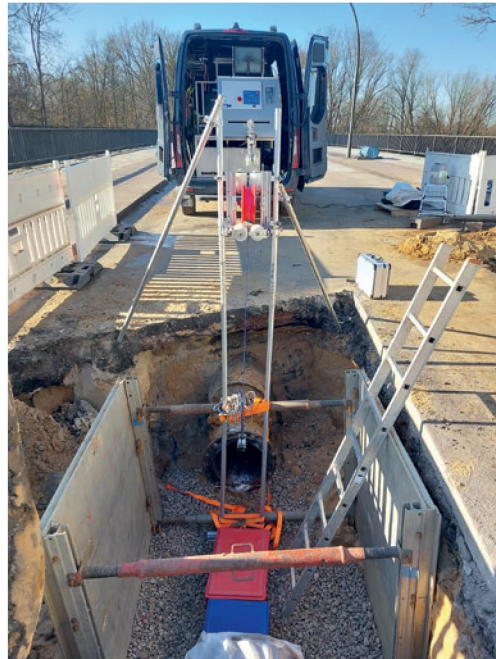
Abb. 1 (links): Untersuchung in einem Trinkwassernetz mit Schiebekamera unter Druck
